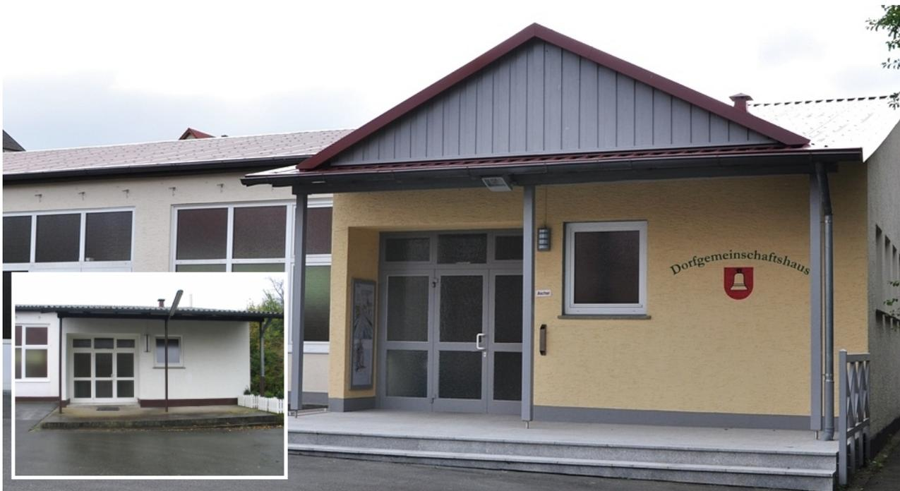
2011 Sanierung des Daches. Zum Teil in Eigenleistung wurde das Dach des Dorfgemeinschaftshauses Beller erneuert. Die Geschossdecke wurde gedämmt und eine neue Dachhaut eingebaut. In diesem Rahmen wurde auch der Eingangsbereich modernisiert.
