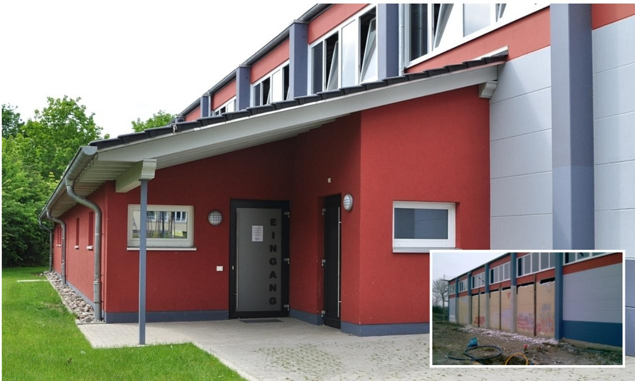
2011 Komplettsanierung der Sporthalle. Die vorhandene, über Jahre nicht genutzte Halle wurde saniert. Die großen Lichtbänder der Halle wurden mit einer Isolierverglasung umgesetzt. Für die Beheizung wird eine moderne Deckenstrahlheizung eingesetzt. Der Anbau für Umkleiden und Sanitäranlagen erfolgte unter Berücksichtigung der aktuellen EnEV Vorschriften.
