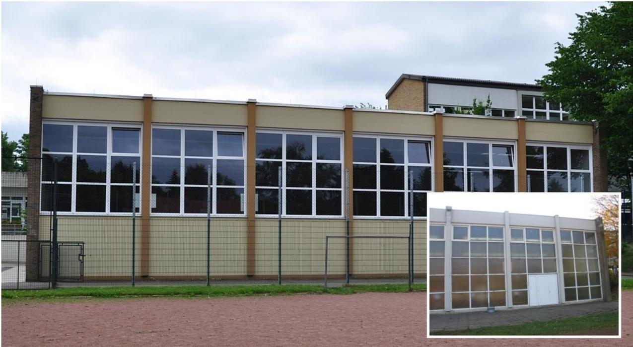
2007 Energetische Sanierung der Sporthalle. Großflächige Fensterfassaden in 1-fach Betonverglasung wurden demontiert. Im unteren Bereich der Fassade wurden Mauerwerksbrüstungen mit Vollwärmeschutz eingebaut, der obere Teil wurde mit energiesparenden Fenstern ausgestattet.
